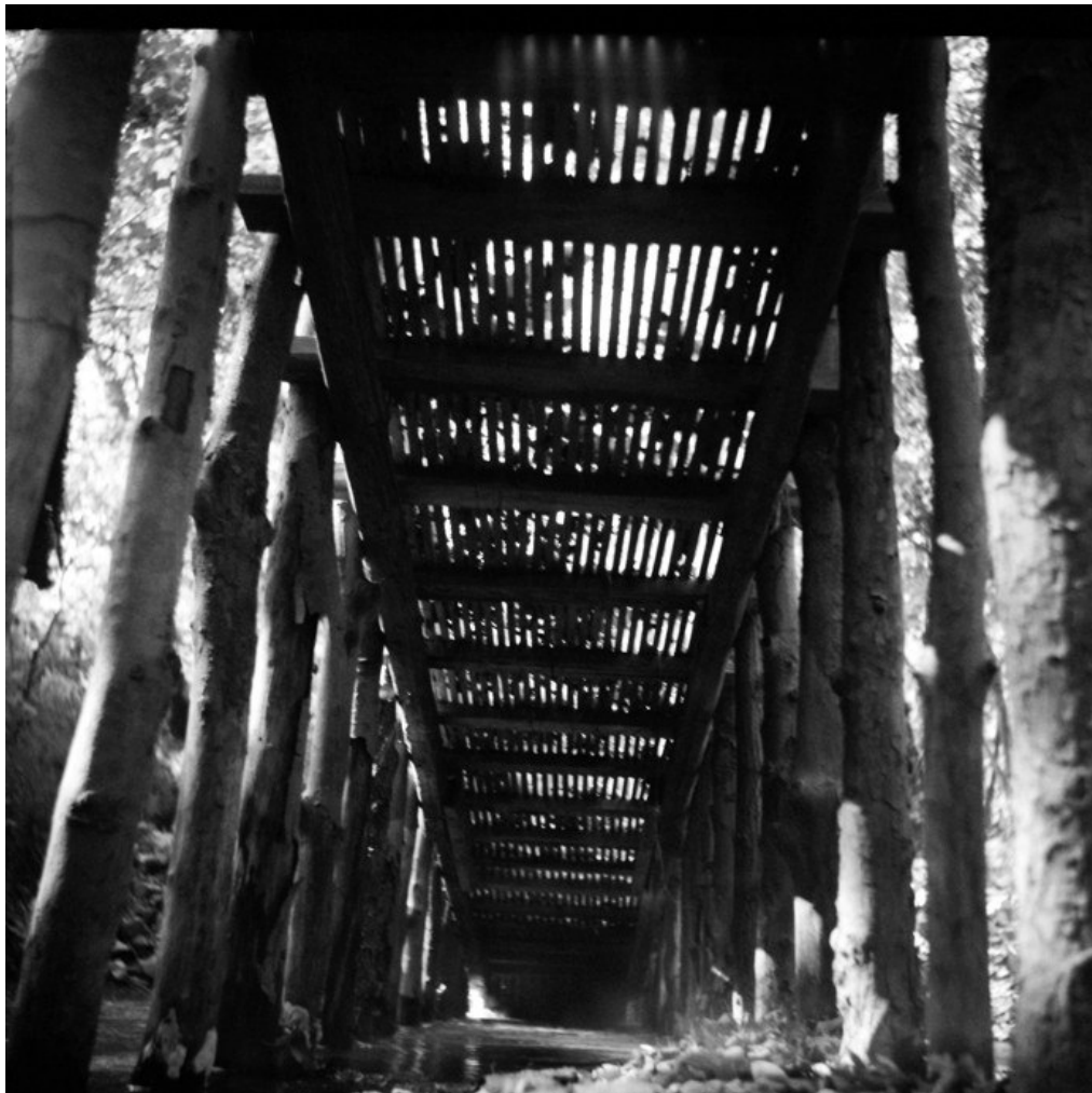
Εικ.4. Αποψη της ιχθυοπαγίδας από κάτω. Ο πάτος και τα πλαϊνά του καναλιού είναι έτσι κατασκευασμένα, ώστε να αφήνουν το νερό να περνάει και να συγκρατούν τα ψάρια.
